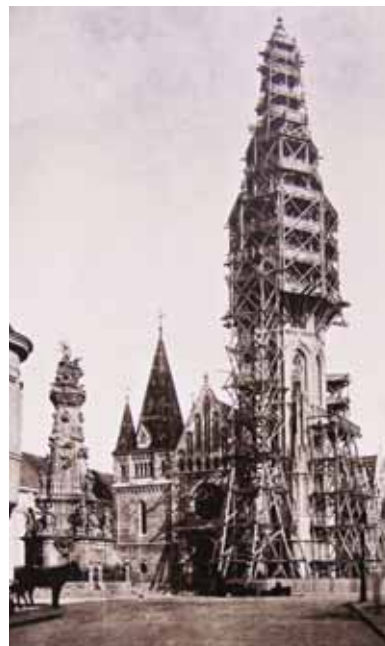
A Mátyás-templom helyreállítás közben (1893)
