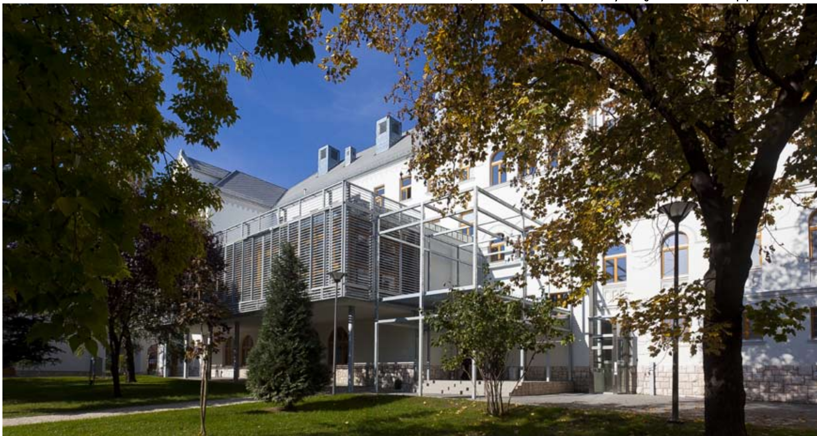
Az elmozdítható, fémlamellás árnyékolófelület könnyed eleganciát kölcsönöz az új épületrésznek
