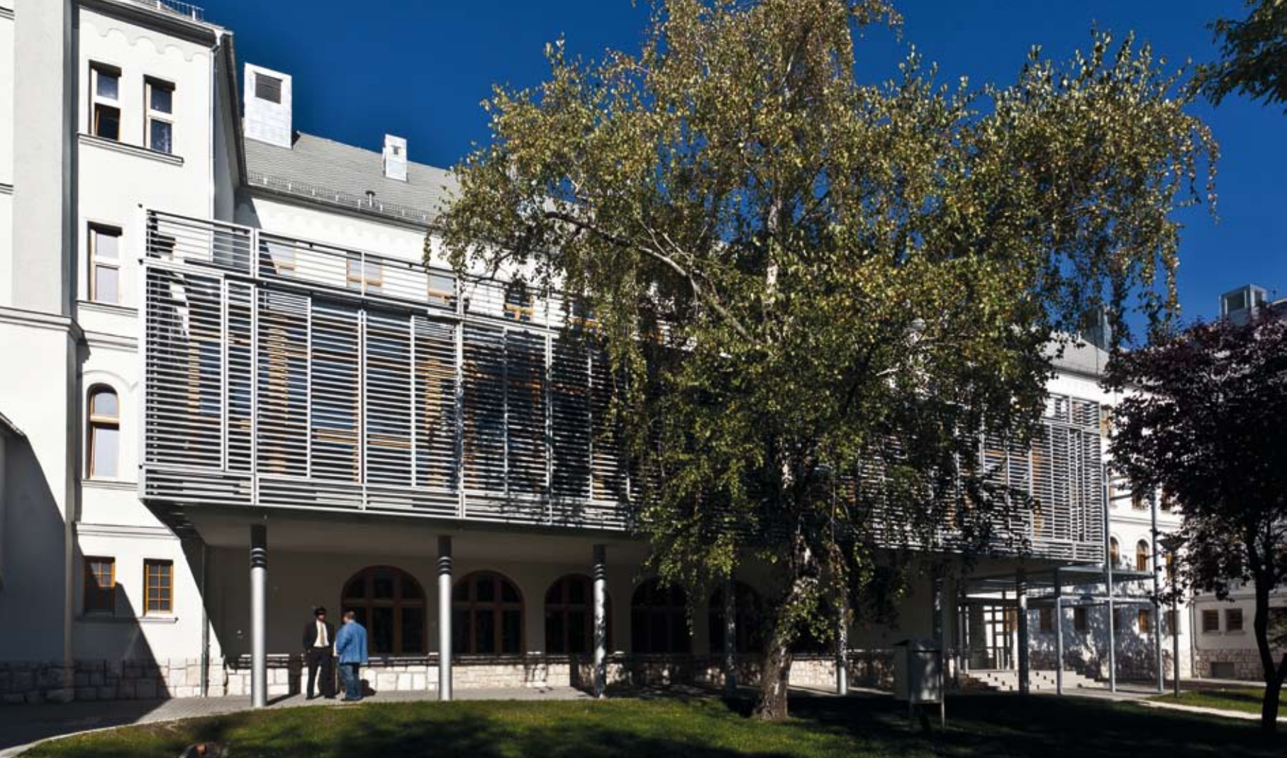
Az udvari oldalon megjelenő karcsú acél-beton oszlopsor támasztja alá a szenátusi tér tömegét
