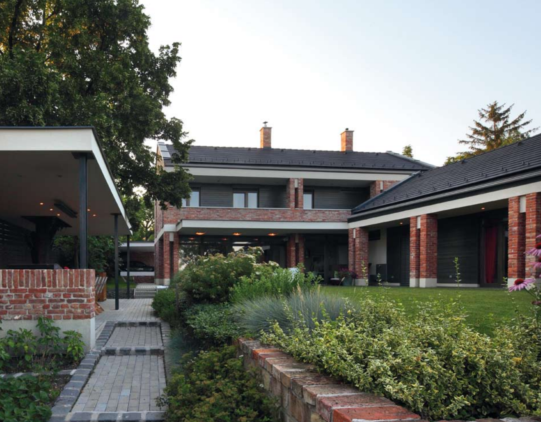
A nyári konyha felől pillantva tárulnak fel a részleteiben kidolgozott, energetikailag is jó, határozott vonalakkal megrajzolt épület (a végigfutó fehér övparkány, helyenként a tetőparkány esetében szó szerint is) építészeti és táji kapcsolatai
