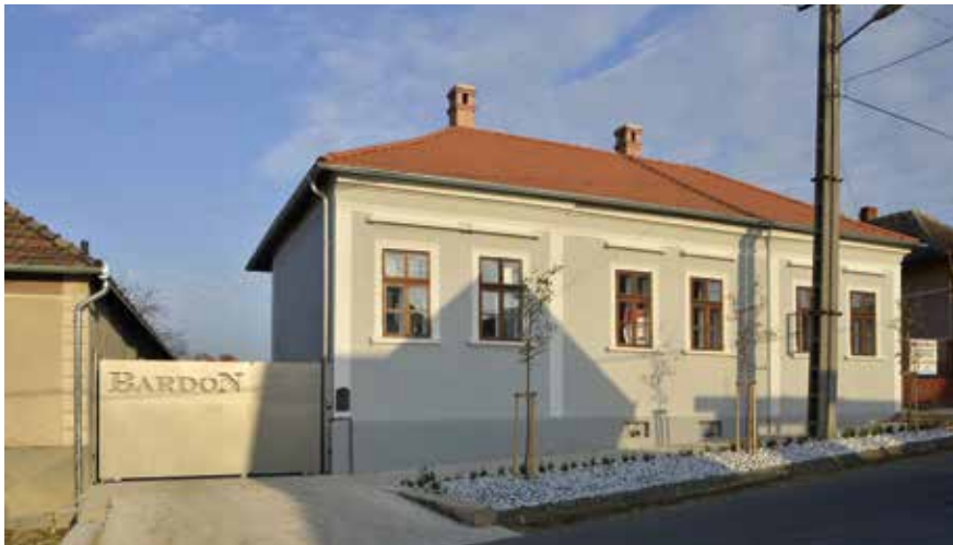
Karádi-Berger Borászat és Vendégház, felújítás, Erdőbénye.
