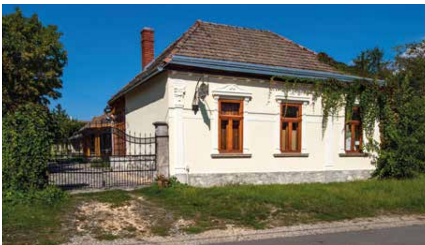
Zimmermann borozó, felújítás, Abaújszántó.
