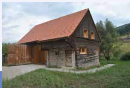
Csobotfalva – Lakóház Építész: András Szabolcs
