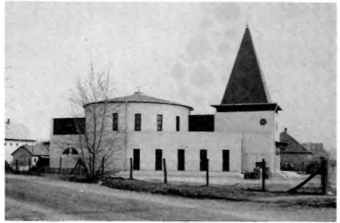
Felsőpakony, római katolikus templom
