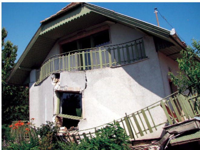
3. ábra. A dunaszentmiklói földcsuszamlás során életveszélyessé vált nyaraló, és a földmozgás okát feltáró földtani felvételi térkép (a nyíl a földcsuszamlás helyét jelzi)
