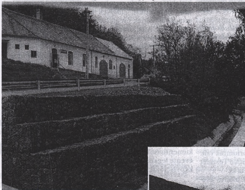
Mórág, gabionelemes partfal védmű
