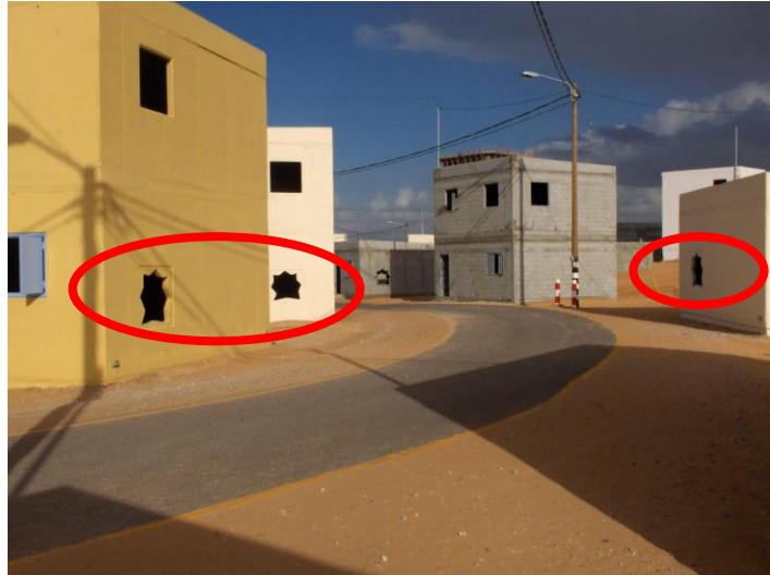
3. kép: Előre elkészített nyílások a MATBAT–B-ben
