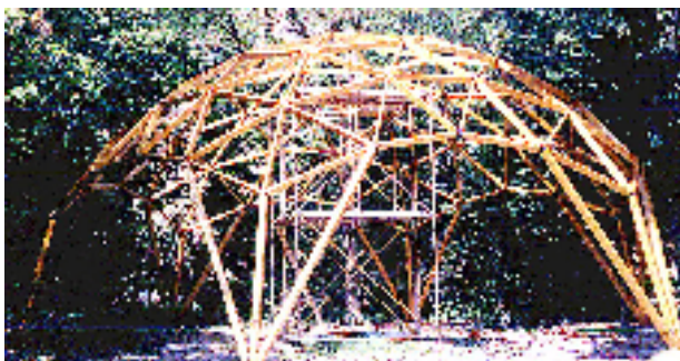
3. ábra – A háromszög rácsszerkezet burkolás előtt.
