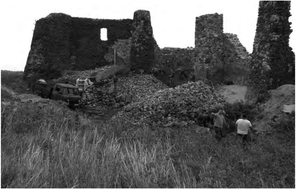
A keleti várfalnál folyó munkálatok 2008 őszén
