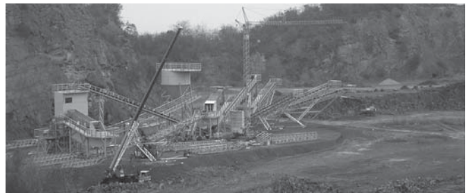
1. ábra A dunabogdányi technológiai sor építése
