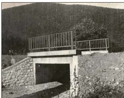
Az Oldal-völgyi híd
