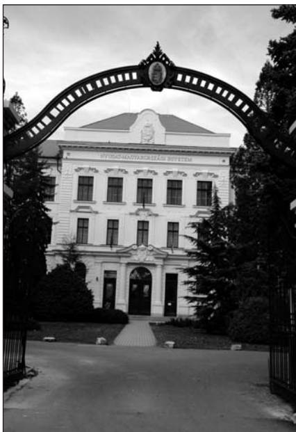
A felújított főépület...
