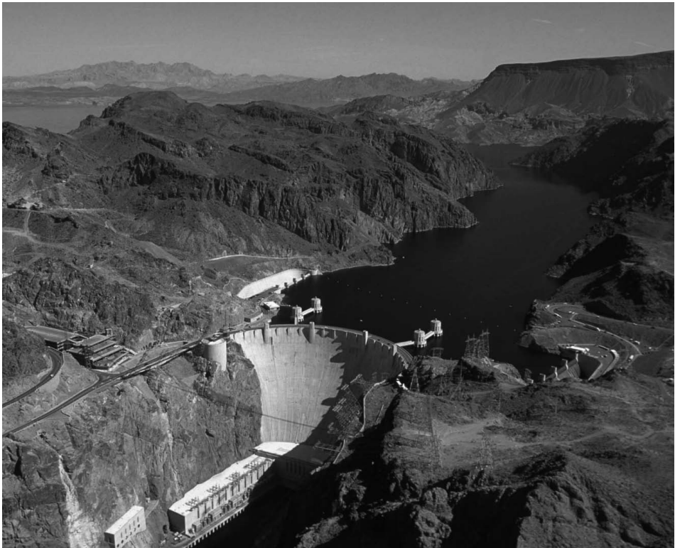
2. ábra • A Hoover-gát vízerőmű, épült: 1931–1935. (forrás: hu.wikipedia.org/wiki/Hoover-gát )
