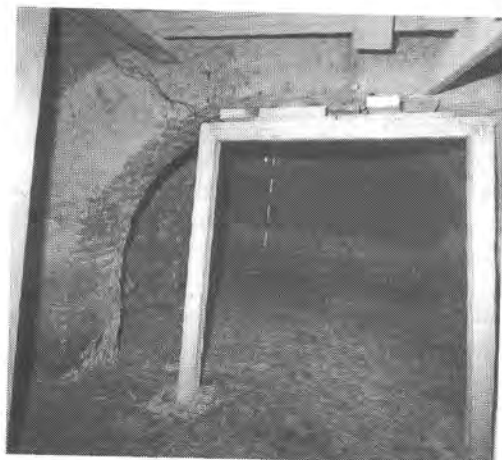
A Főparancsnokság keleti szárnyában található középkori mélypince északi szakasza
