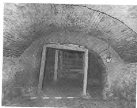
Az épület keleti szárnyában feltárt középkori mélypince lejárata északi irányból.
