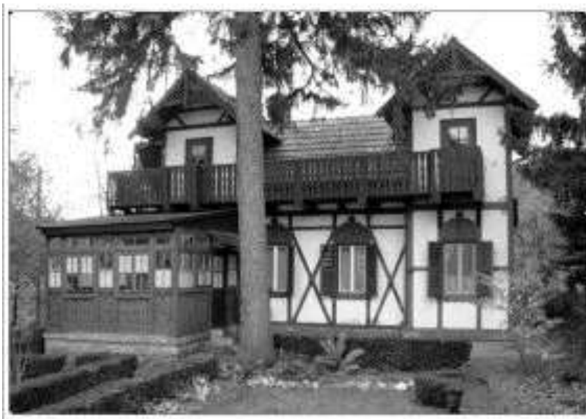
2. kép. Favázas nyaralóépület, zárt faverandával, Felsőöhrházköz 4. Boór Ferenc, 1892
